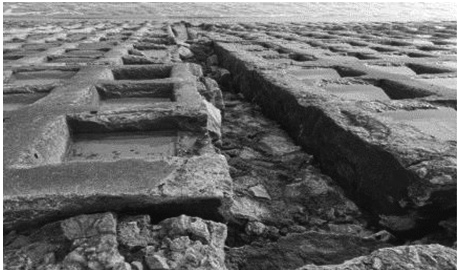
a) 平台下槽型块护坡损毁严重
