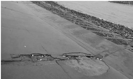
d) 平台上混凝土护坡表面局部破损
