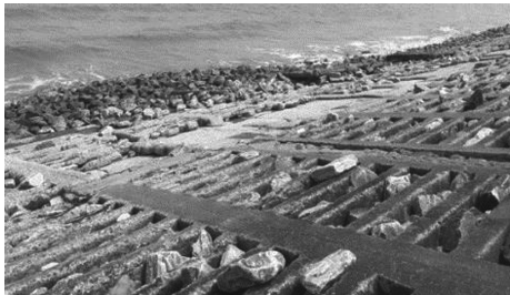
图 4 护底结构失稳情况
