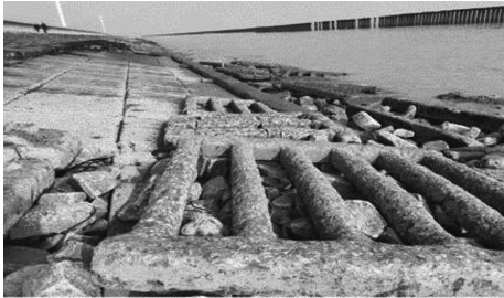
b) 平台下栅栏板脱落移位
