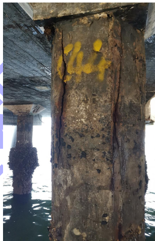
图 2 既有六角形桩桩顶裂缝
