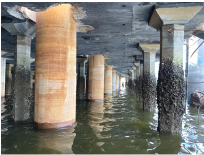
图 12 钢护筒施工完成
