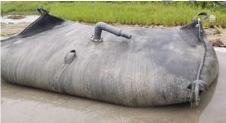
b) 扁平管袋充填一周脱水效果
