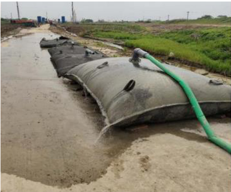
a) 泵送淤泥充填管袋过程
