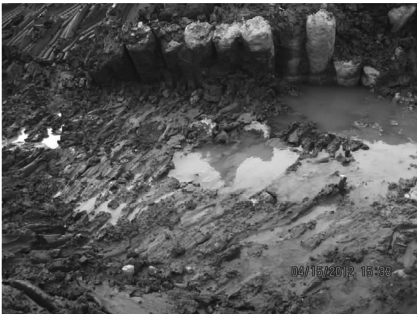
图 5 现场挡墙失稳、断桩
