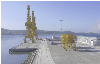
图 5 某多用途码头在码头前方设置铁路装卸线
