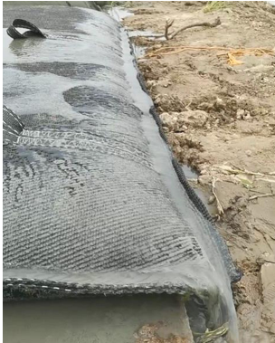
图 6 滤出水情况 对土工管袋滤水和固化底泥进行采样检测, 水质检测结果见表 5, 固化底泥成分见表 6。
