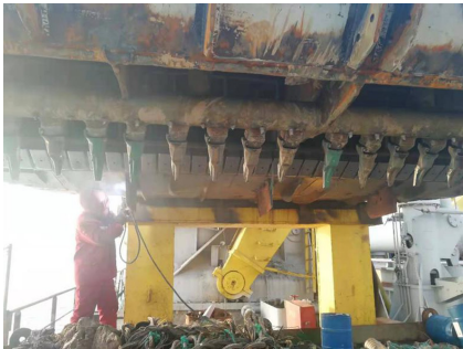
图 6 加焊导向立板
