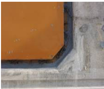
图 8 钢封门内外接缝均刷高强止水胶
