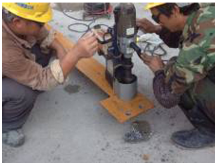
图 9 现场实测后用磁力钻开孔
