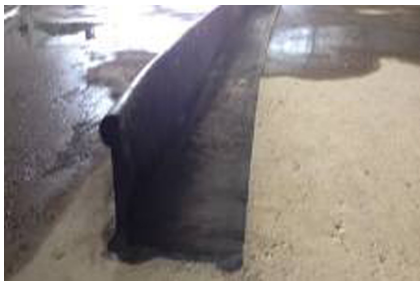
图 7 定型加工 2 cm 厚 L 型止水条
