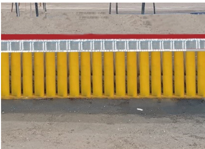
图 1 密排桩式堤结构
