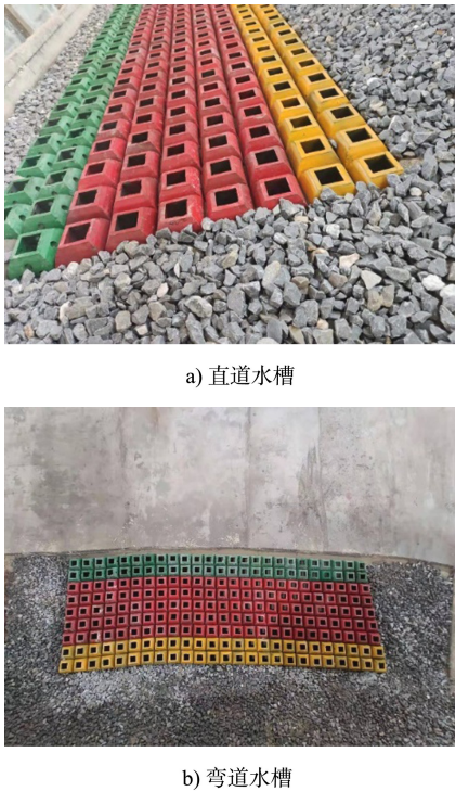
图 7 护坡结构试验段效果
