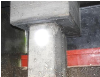
a) 桩顶混凝土破损
