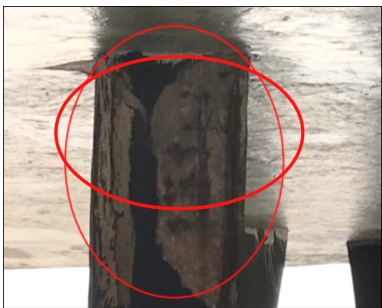
c) 桩身混凝土剥落、露筋锈蚀
