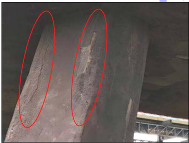
b) 桩身开裂、局部混凝土破损
