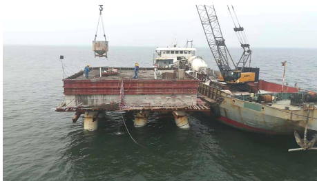
图 2 多功能船上吊罐浇筑系统墩混凝土
