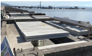
图 10 原引桥透空段铺设盖板
