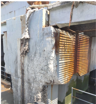
图 6 磨损严重的靠船构件
