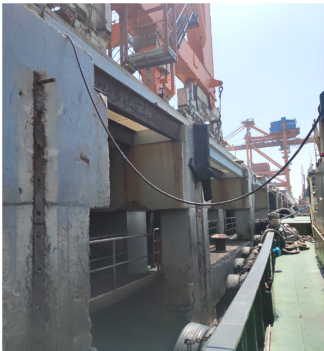
图 5 受损脱落的码头护舷
