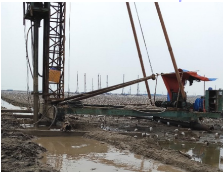
图 4 黏土密封墙施工现场
