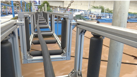
图 3 滚轴式电缆桥架
