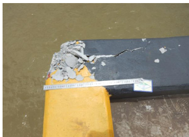
图 2 护轮坎遭撞击破损
