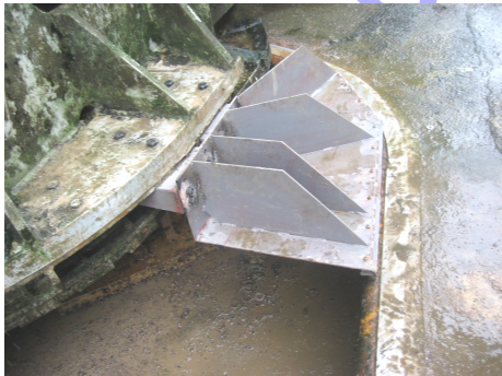
图 4 人字门底止水防卡阻装置安装效果
