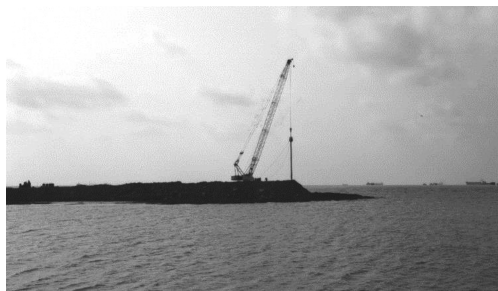
图 4 超高填石后爆炸前堤头隆起淤泥包
