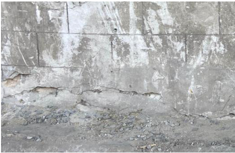
图 7 1 # 泊位码头面后方仓库地坪裂缝
