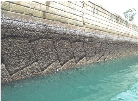
图 2 重力式码头方块结构
