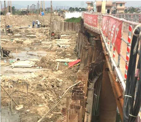
图 3 钢板桩围堰偏位
