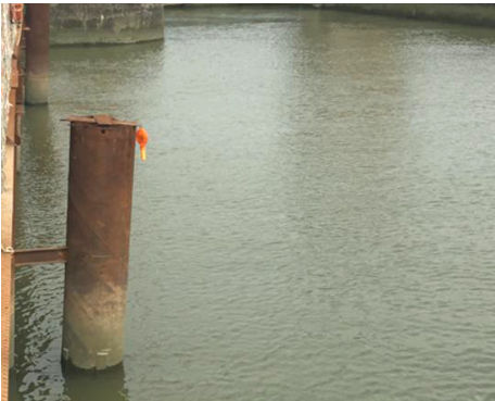
图 4 人行栈桥桩基偏位
