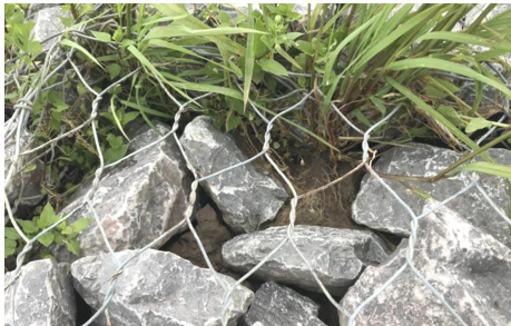
图 1 钢丝网石笼护坡
